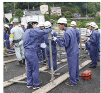
東別府駅近くの日豊本線を跨ぐ、跨線橋の建設現場の見学会では、工事見学に加えて、足場組立競争をしました。
